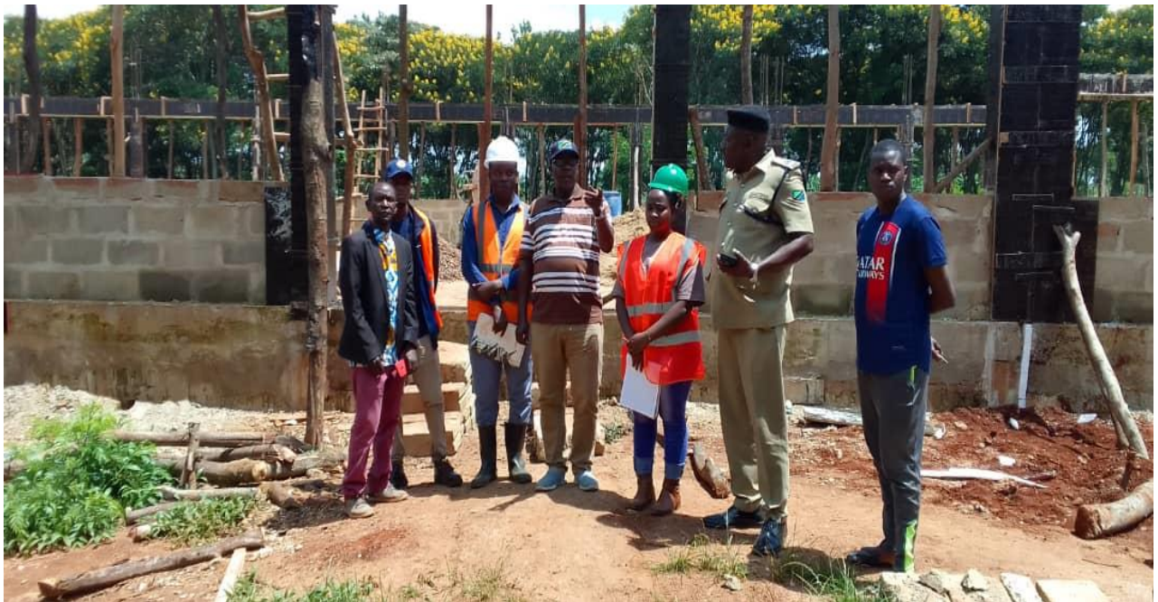
Mkuu wa Wilaya Ngara Kanali Mathias J. Kahabi akikagua jengo la Bwalo la chakula katika shule ya sekondari ya juu ya wanaume Ngara tarehe 17.02.2024.
