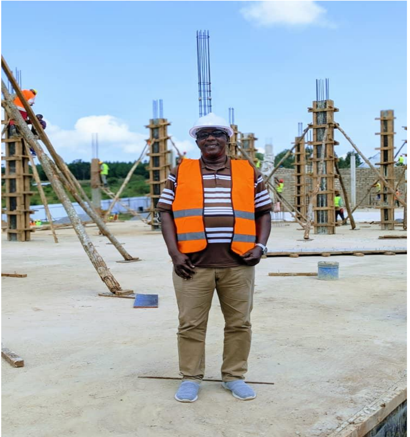
Mkuu wa Wilaya Ngara Kanali Mathias J. Kahabi akikagua sehemu ya jengo la soko kwa ndani
