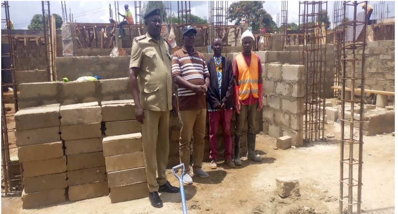
Mkuu wa Wilaya Ngara Kanali Mathias J. Kahabi akikagua jengo la makao makuu ya Halimashauri ya Wilaya tarehe 17.02.2024.
