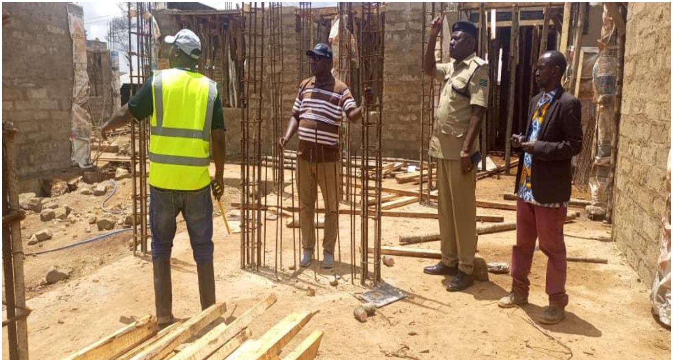
Mkuu wa Wilaya Ngara Kanali Mathias J. Kahabi akikagua jengo la makao makuu ya Halimashauri ya Wilaya Ngara tarehe 17.02.2024.
